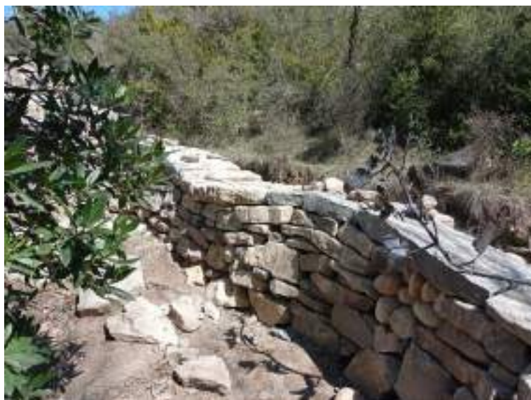
Ilustración 3 Murete recuperado e intervenido durante la última semana de marzo de 2025 en el Camping el Puente de Rodellar, por La Equipa (Sandrine e Inma), Javier Opic (Murets d'art, Francia) junto a la AGMC (Albert y Brice) y con obra en forja de Paco Puch
